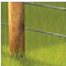
Sin Vegetación Sin contacto entre vegetación y el alambre del cerco eléctrico
