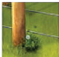
Baja Vegetación Vegetación ocasionalmente toca el alambre del cerco eléctrico.
