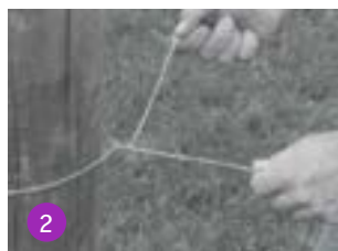
2 Enrolle el extremo libre del alambre al rededor del alambre tenso 3 veces.
