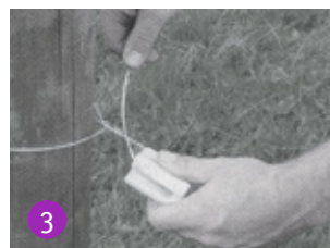
3 Inserte el extremo libre del alambre en el aislador.
